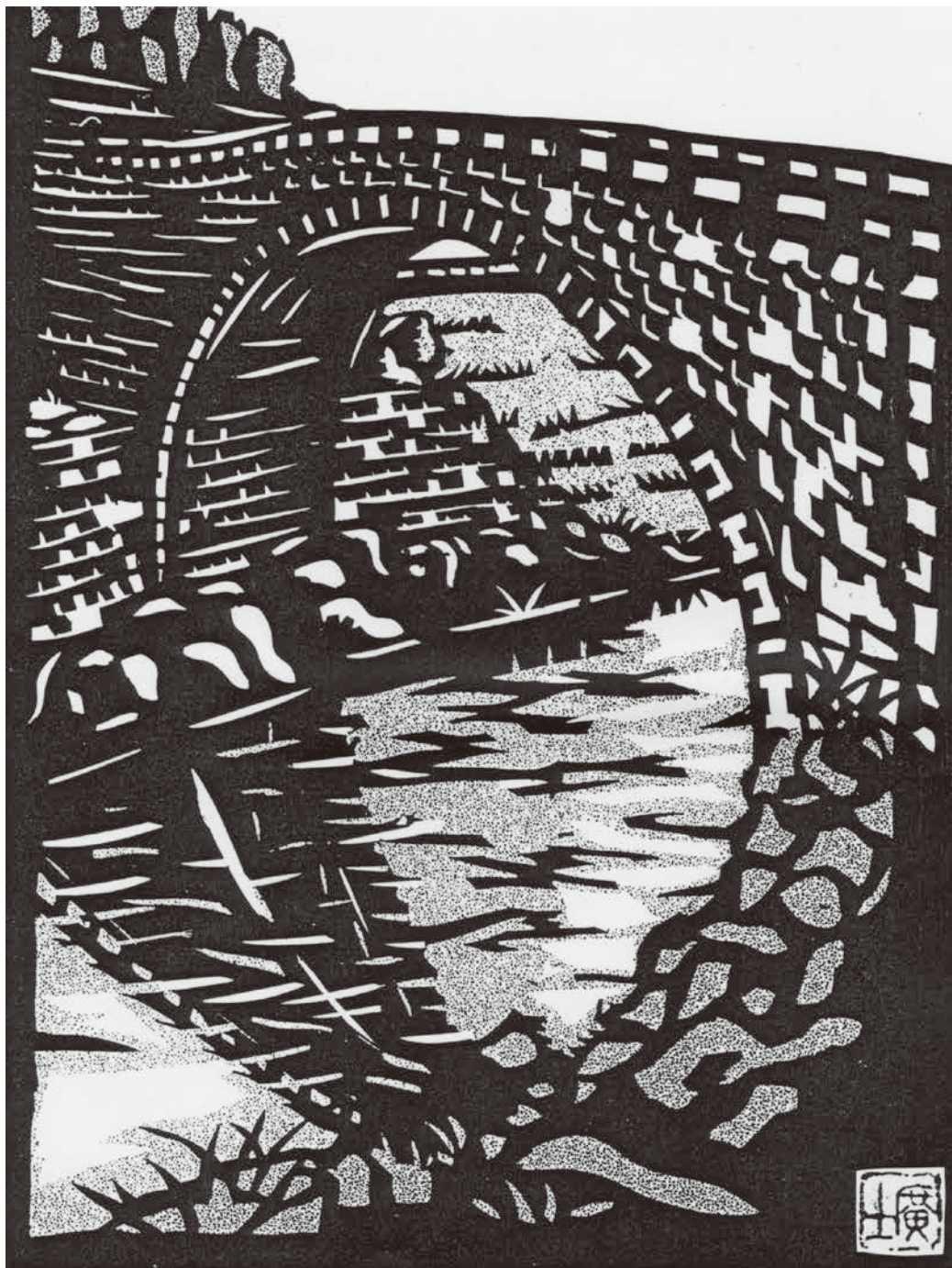
霊台橋(れいだいきょう) ~熊本県 美里町~
